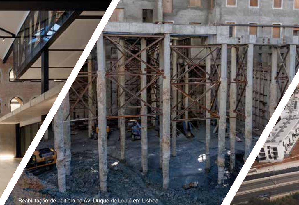
Obra de reabilitação em edifício da Fidelidade em Lisboa
